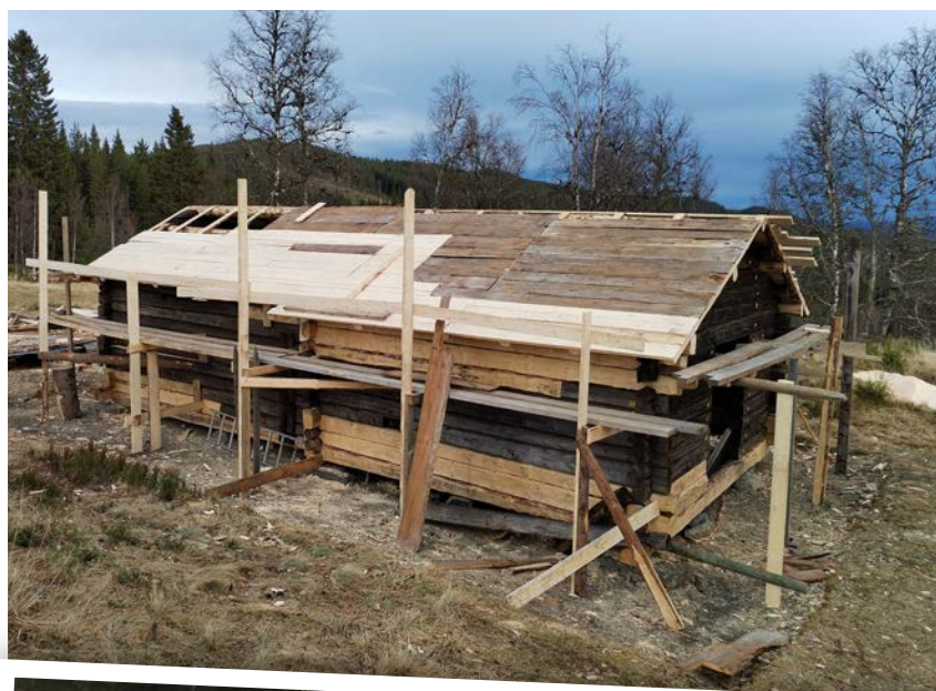
Arbeidet med bygget startet i begynnelsen av september, etter at tomte var planert og klargjort. Bygget hviler foreløpig på hjørnesteiner – mur og steinsetting gjenstår.
