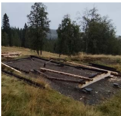
Arbeidet med bygget startet i begynnelsen av september, etter at tomte var planert og klargjort. Bygget hviler foreløpig på hjørnesteiner – mur og steinsetting gjenstår.
