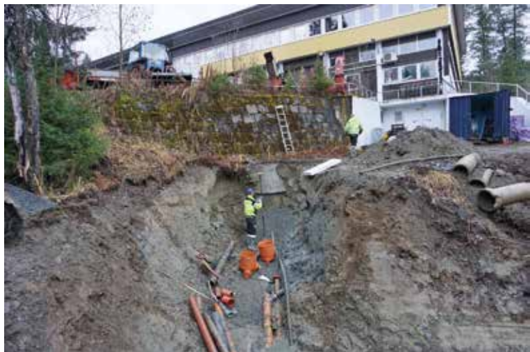
Arbeid med vatn og avløp. Bilde på jordstykke like nord for Skogbrukets hus.
